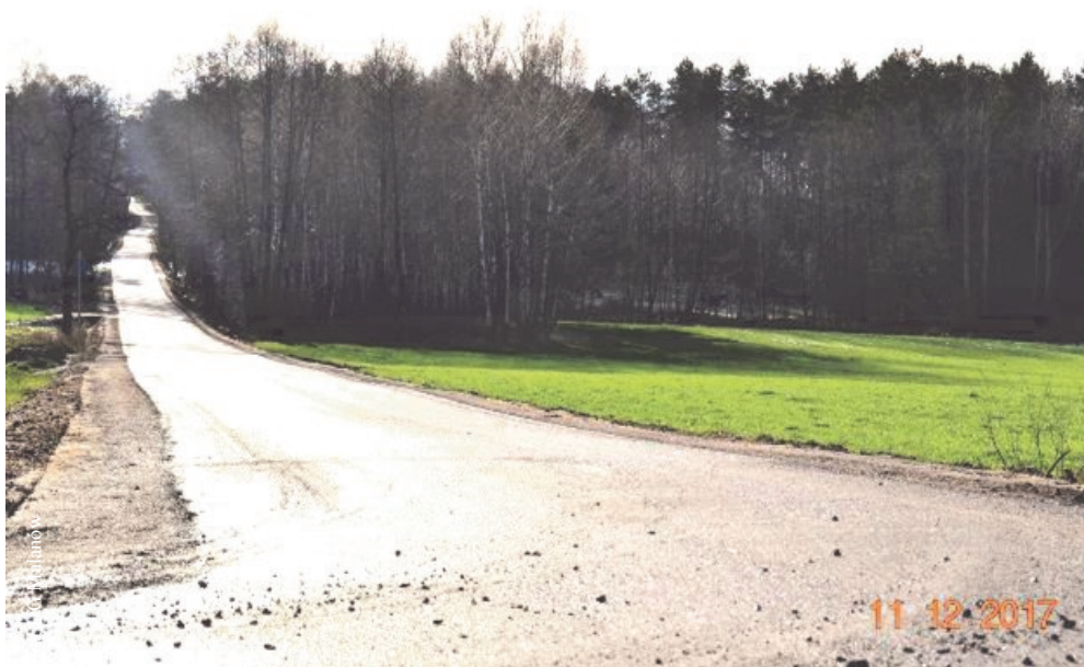
Przebudowa drogi w Kotwasicach
