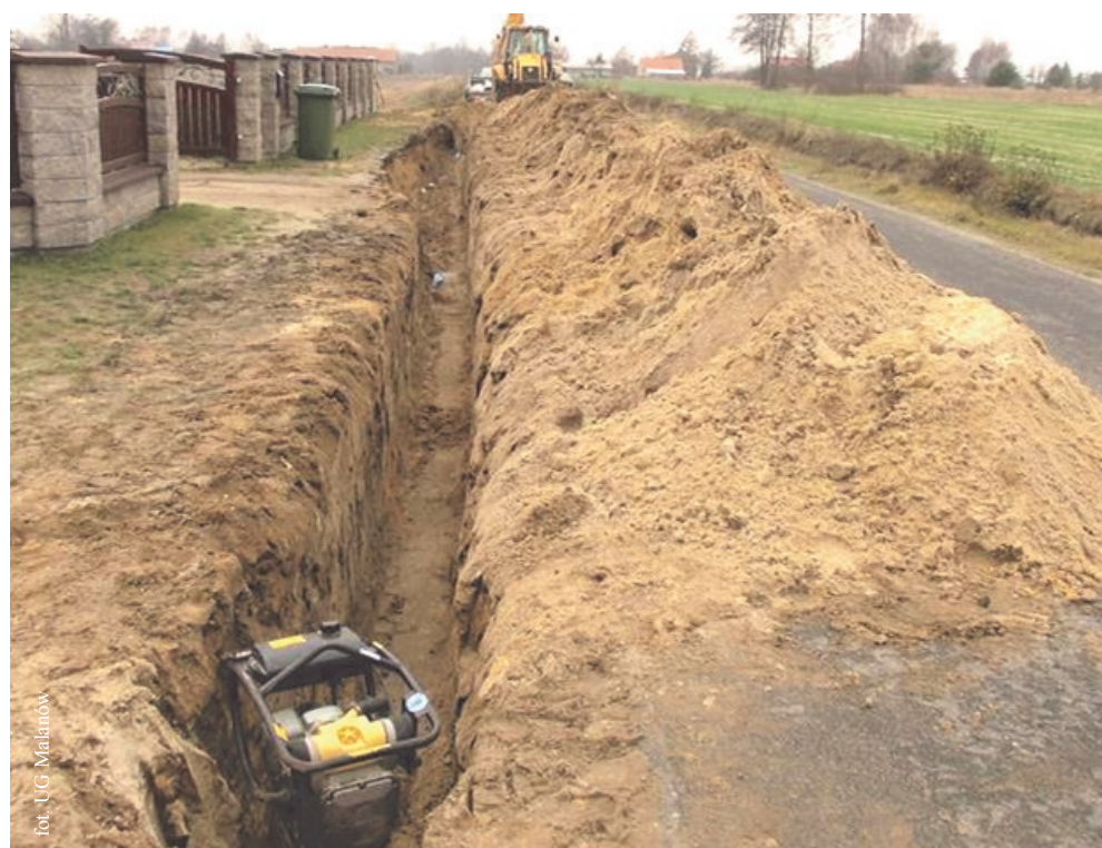
Przebudowa i rozbudowa sieci wodociągowej przy ul. Kwiatowej
