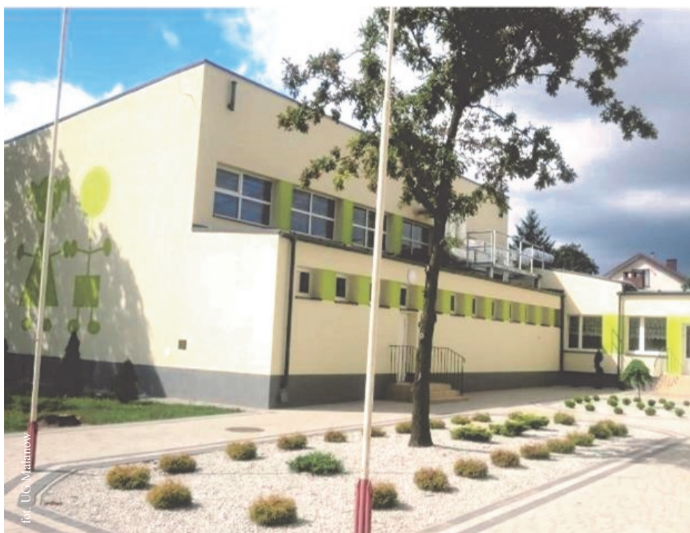
Modernizacja energetyczna budynku SP w Malanowie
