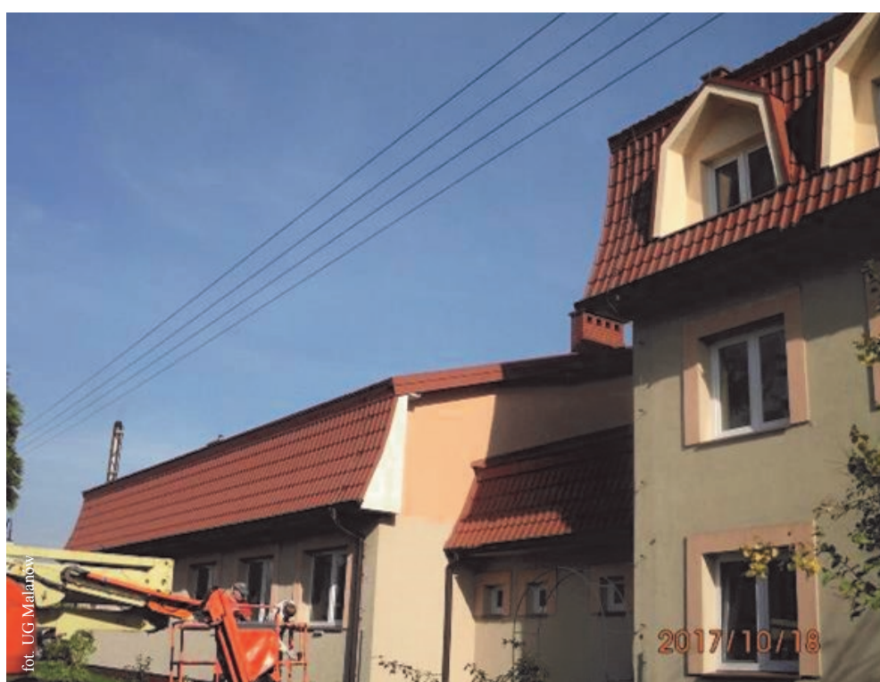
Prace remontowo-adaptacyjne w budynku ŚDS
