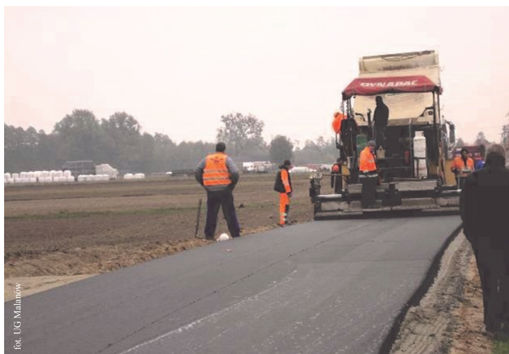
Budowa drogi w Porożu
