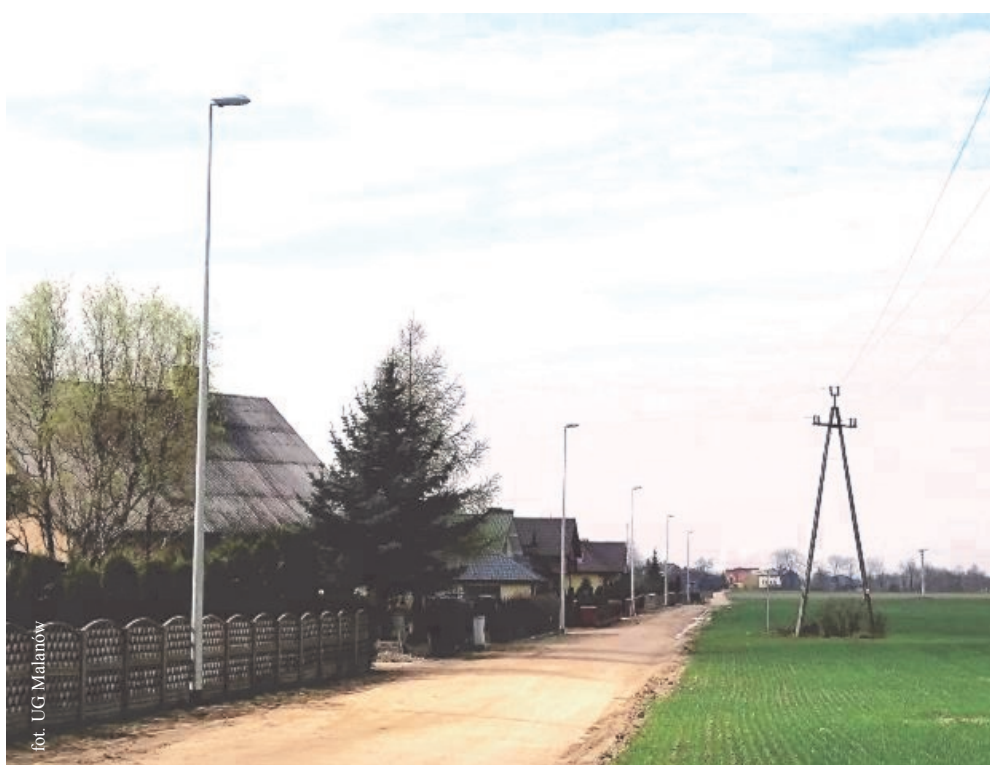
Budowa oświetlenia drogowego w Malanowie na ul. Nowej
