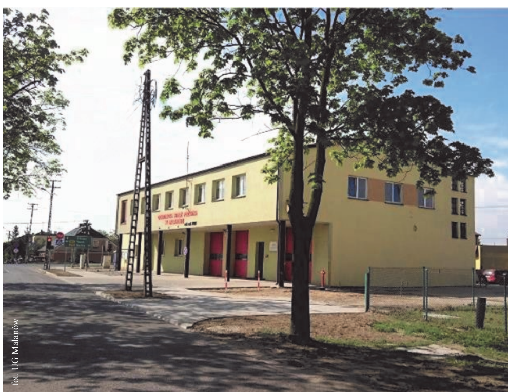
Utwardzenie placu przy Świetlicy Wiejskiej w Malanowie
