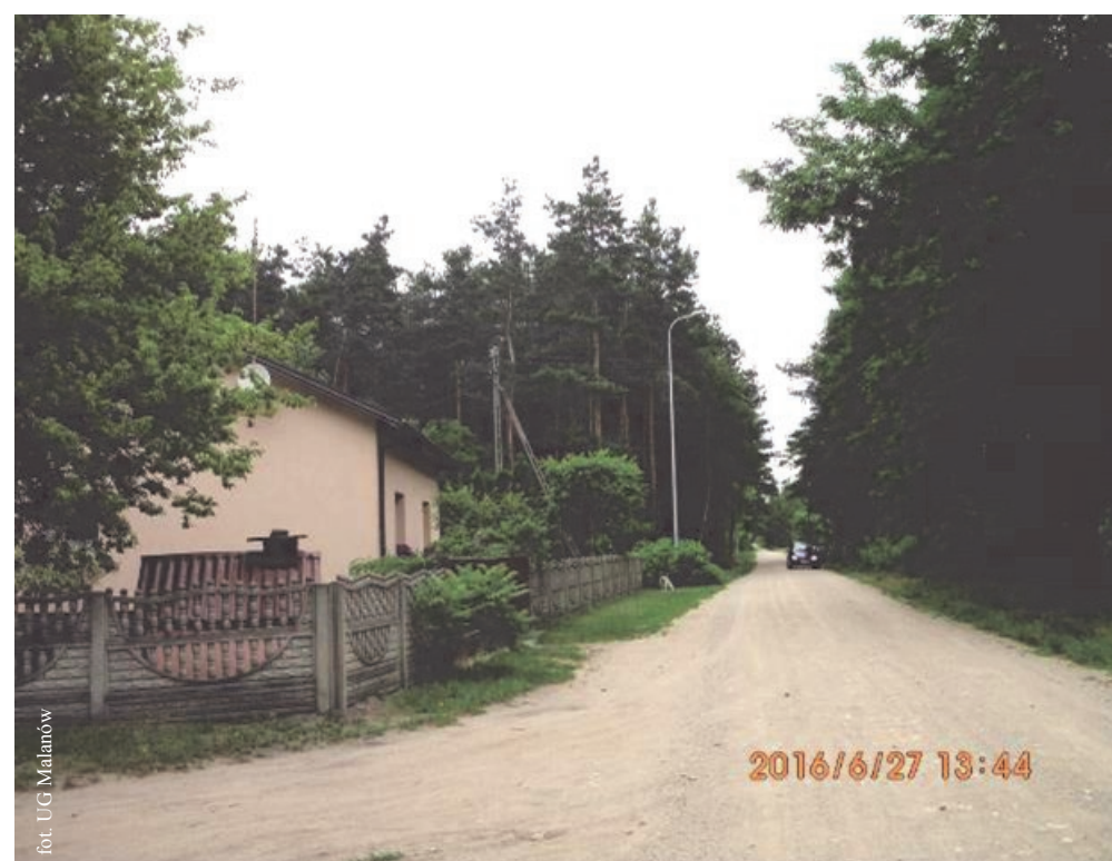
Budowa oświetlenia drogowego w Kotwasicach
