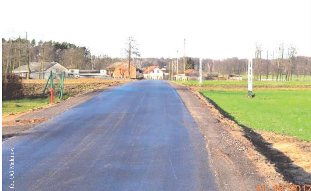
Przebudowana droga Targówka-Grąbków
