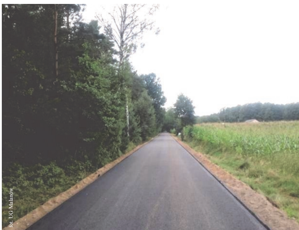
Modernizacja drogi w m. Żdzenie i Grąbków
