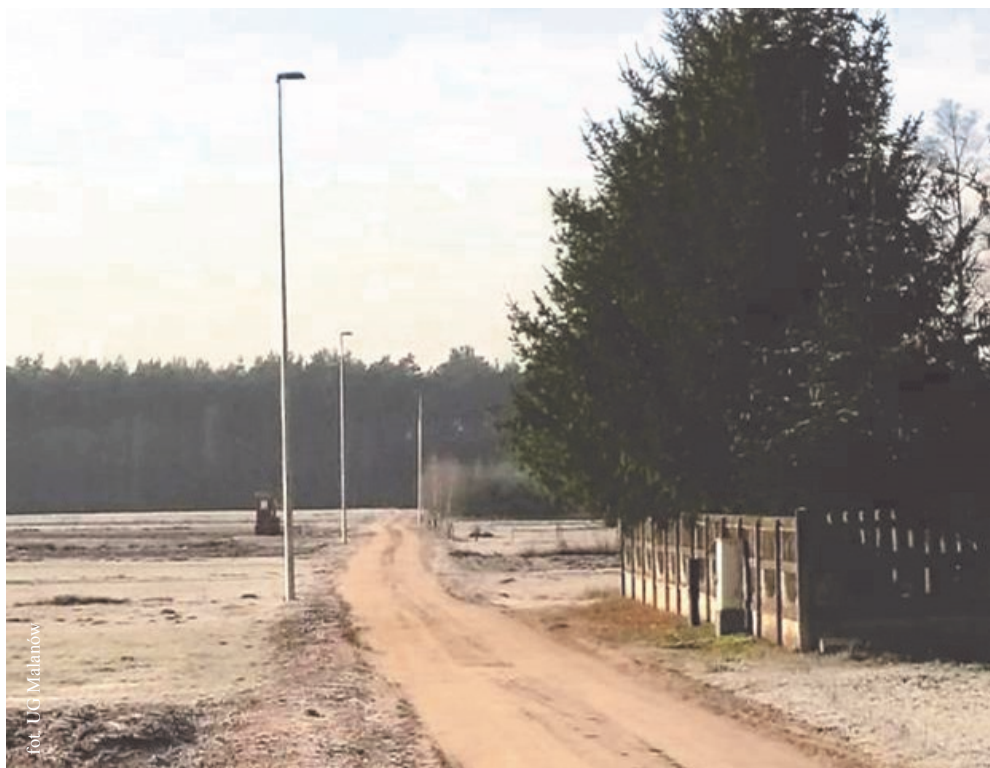
Budowa oświetlenia drogowego w Dziadowicach
