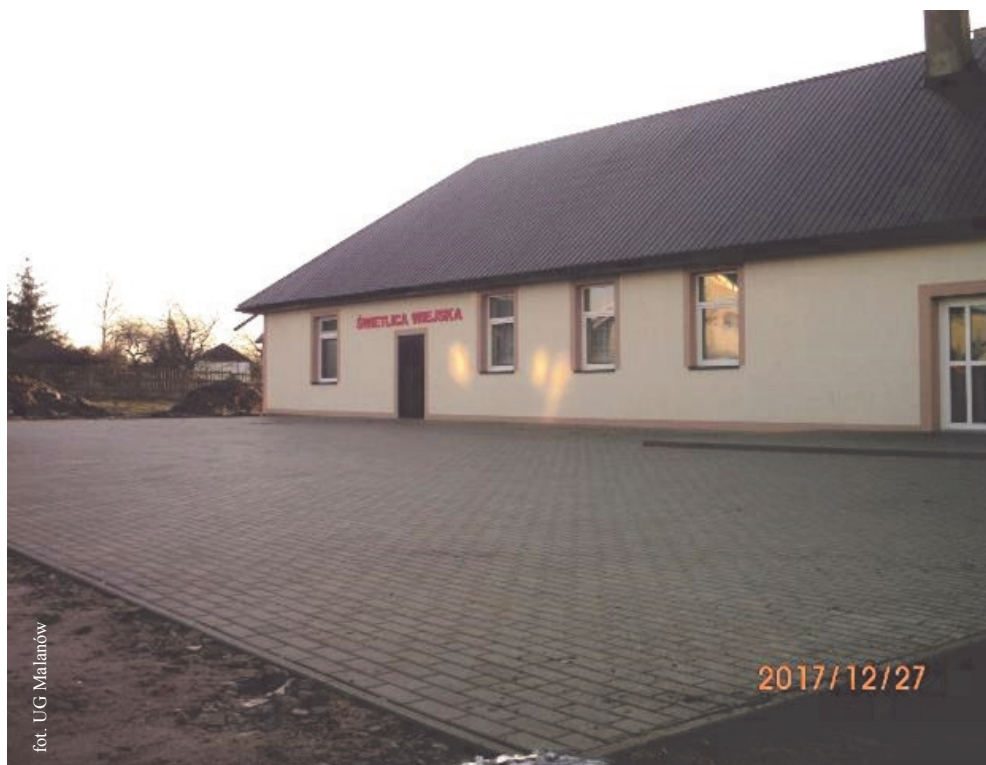
Utwardzenie placu przed Świetlicą Wiejską w Dziadowicach
