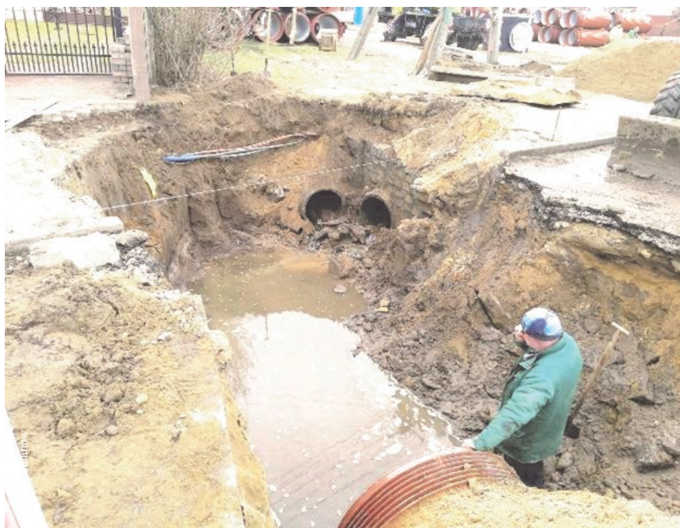
Budowa kanalizacji wodnej w Malanowie
