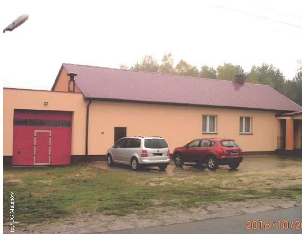
Termomodernizacja wraz z poprawą estetyki Świetlicy Wiejskiej w Bibianie
