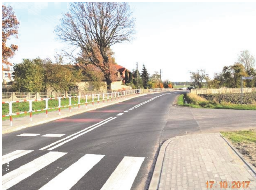
Przebudowa drogi powiatowej na odcinku Miłaczew – Skarżyn współfinansowana ze środków budżetu Gminy Malanów
