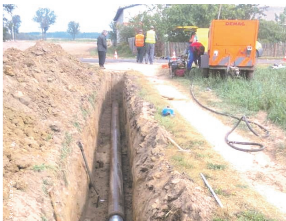
Budowa wodociągu gminnego
